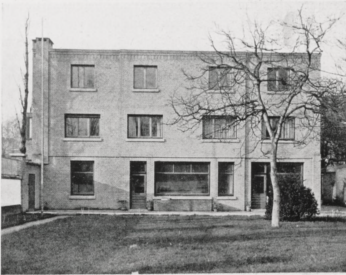
Habitation du D r Y., à Courtrai. Façade latérale vers le jardin. Photo : Duqueenne.
